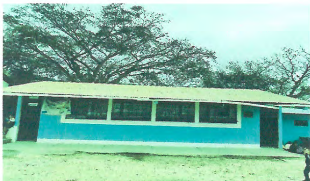
Foto 1: Mejoramiento de techo cubierta y estructura
